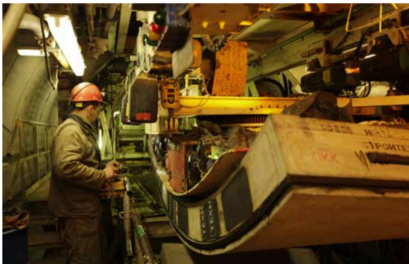
Проходка правого перегонного тоннеля между станциями «Жулебино» и «Лермонтовский проспект» велась с помощью ТПМК Herrenknecht EPB-6340 с января по май 2013 г.
